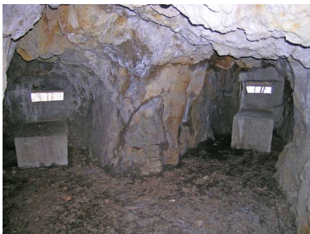
Cuzzago: opera in caverna con postazioni per mitragliatrici
